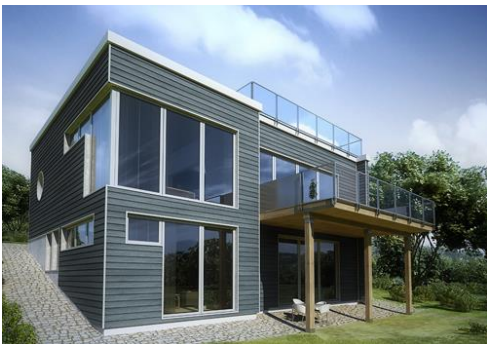
ПОЛНАЯ ОТДЕЛКА ФАСАДА ЗДАНИЯ
